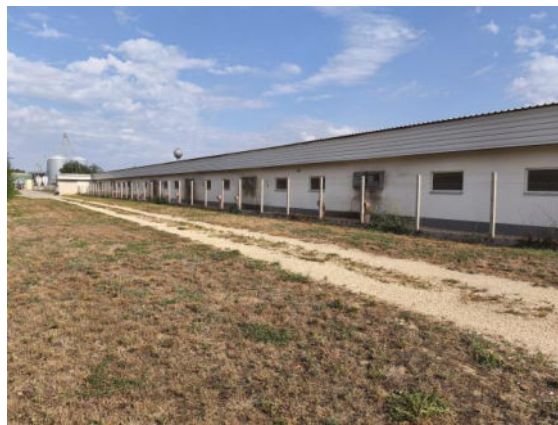
A három 217 m hosszú ól egyike. A falon két világító ablak után ikerventilátorok vannak
